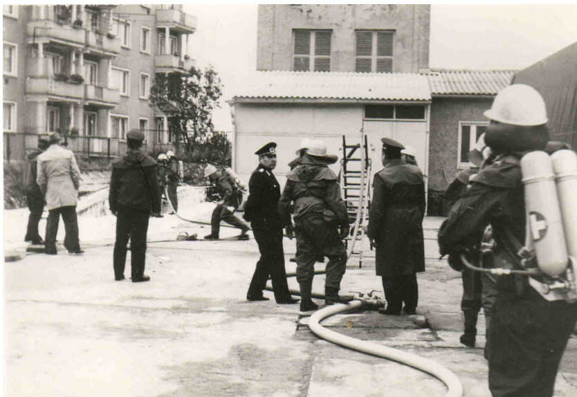
Foto 10 : Freiwillige Feuerwehr Strasburg 1976 bei der Ausbildung. Siegfried Helmig (in Uniform), ehem. Leiter der Abteilung Feuerwehr begutachtet dieselbe. Im Hintergrund gut zu erkennen, die nachträglich angebaute „Annahme“ mit Laderampe.
