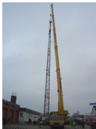
Abriss des Funkturmes am 11.04.2008
