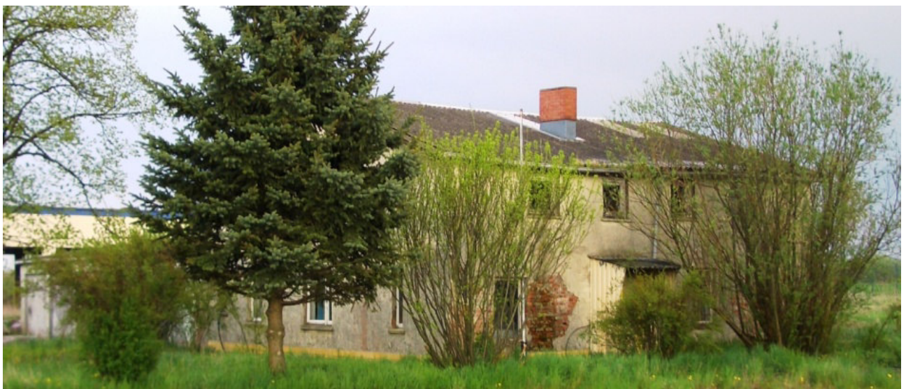
„Haus 2“, ehemalige Büroräume (re.), mit Tragkraftspritzenwerkstatt und Lager sowie Schweißwerkstatt
