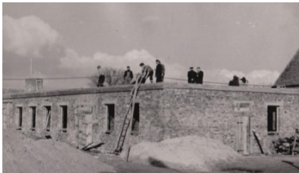
Fotos 7 : Errichtung des Feuerwehrgerätehauses mit anfangs vier Stellplätzen, einem gut ausgestatteten Sozialteil und einer Wohnung nebst Errichtung Funkturm
