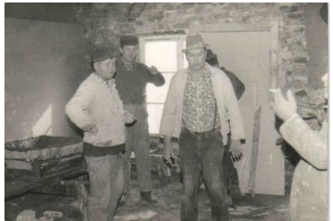
(von li.) Eberhard Lindow (Kreisgerätewart), Peter Thoms, Erwin Hochhaus (teilweise im Bild), unbekannt, Reinhold Jakob (teilweise im Bild), Ausbau der Tragkraftspritzen- Werkstatt
