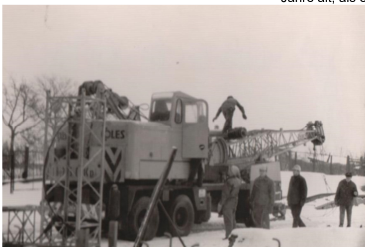
Aufstellung des Funkturms
