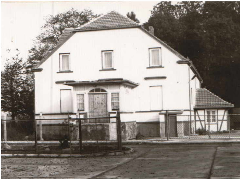
Foto 25 : Ehem. Gutshaus („Haus 1“), genutzt als Büro, Lager, Funkwerkstatt ... Anfangs gehörte nur das ehem. Gutshaus zum „Versorgungsstützpunkt Ziegelhausen“. Das Gebäude blieb bis zum Auszug am 03.11.1995 weitestgehend im Originalzustand erhalten. Notwendige Instandhaltungen wurden (im Rahmen der Möglichkeiten) stets ausgeführt.
