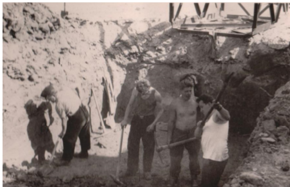
Kameraden der Freiwilligen Feuerwehr beim Ausheben des Fundamentes für den Funkturm. „Handarbeit ist Handarbeit“.
