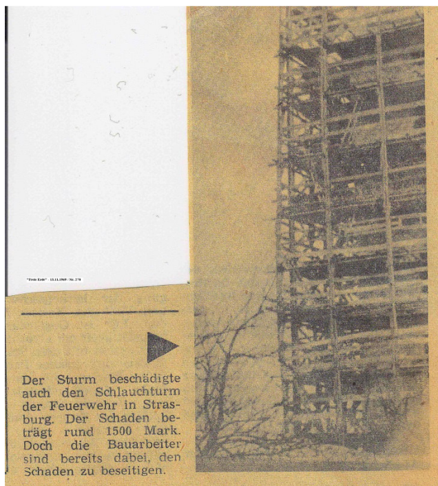
Foto 2 : Artikel aus der „Freien Erde“ v. 13.11.1969 nach einem Sturmschaden während der Bauzeit
